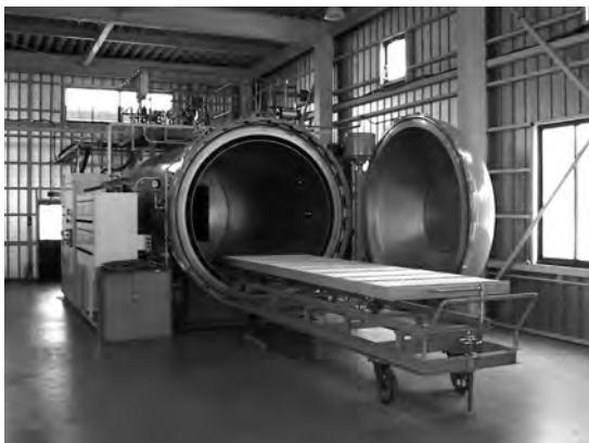
CFRPを硬化成形するオートクレーブ
