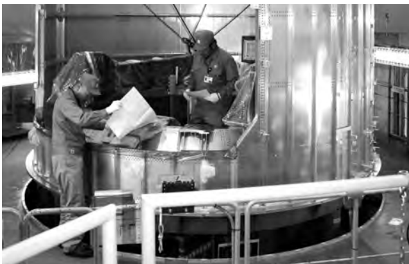
2人1組になり「このとり」の非与圧部に約38,000個の穴を開けリベットを打ち込む。
